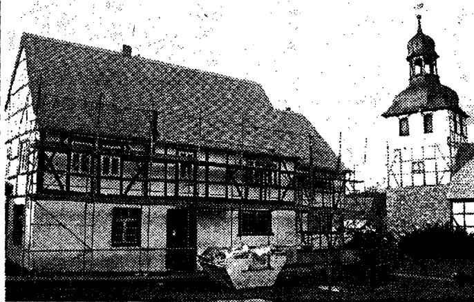
Gegenwärtig erfolgen u.a. umfangreiche Dacharbeiten am Bürgerhaus in Molmerswende. Fotos: Franke
